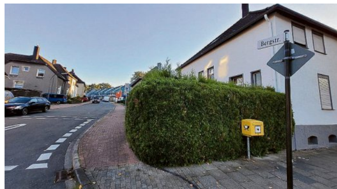
An der Bergstraße in Oer-Erkenschwick sind umfangreiche Arbeiten im Gehwegbereich geplant. Die Fahrbahn wird vorübergehend zu einer Einbahnstraße.
